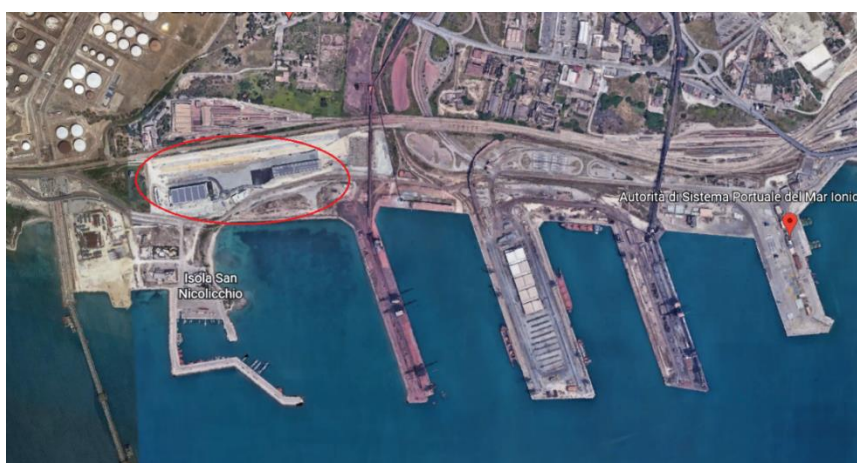
Figura 4.5: indicazione geografica degli Edifici con Impianto FV all'interno del Porto di Taranto
