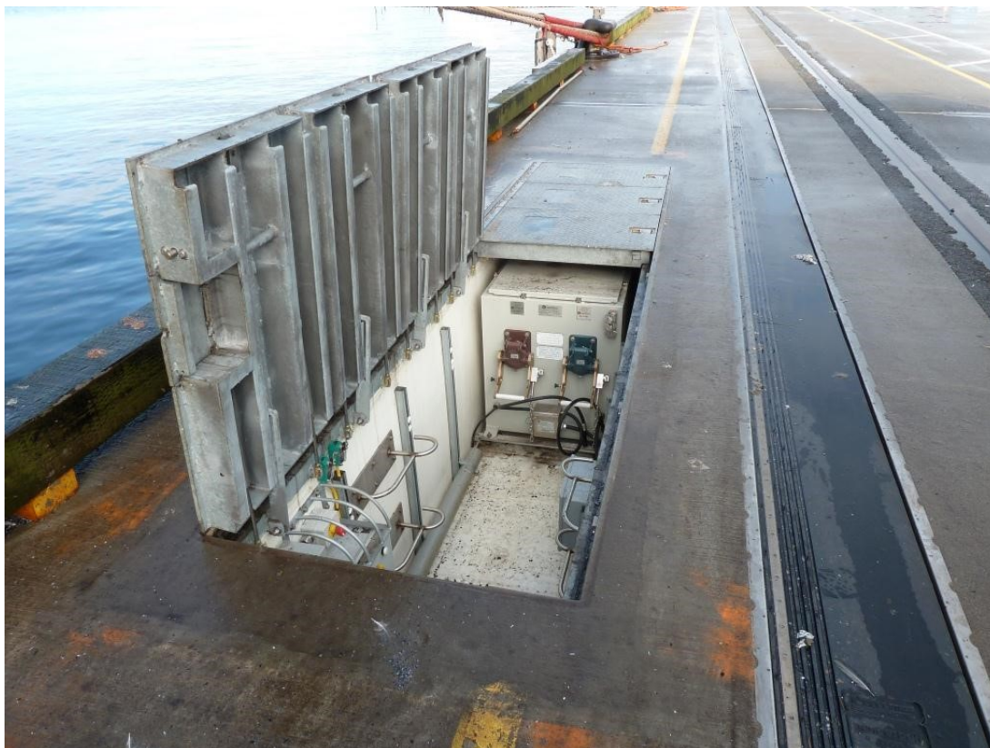
Figura 22: Esempio di interrimento del sistema di conversione
